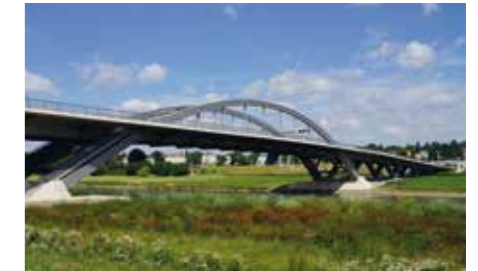
Waldschloesschen Bridge, Dresden / Germany
